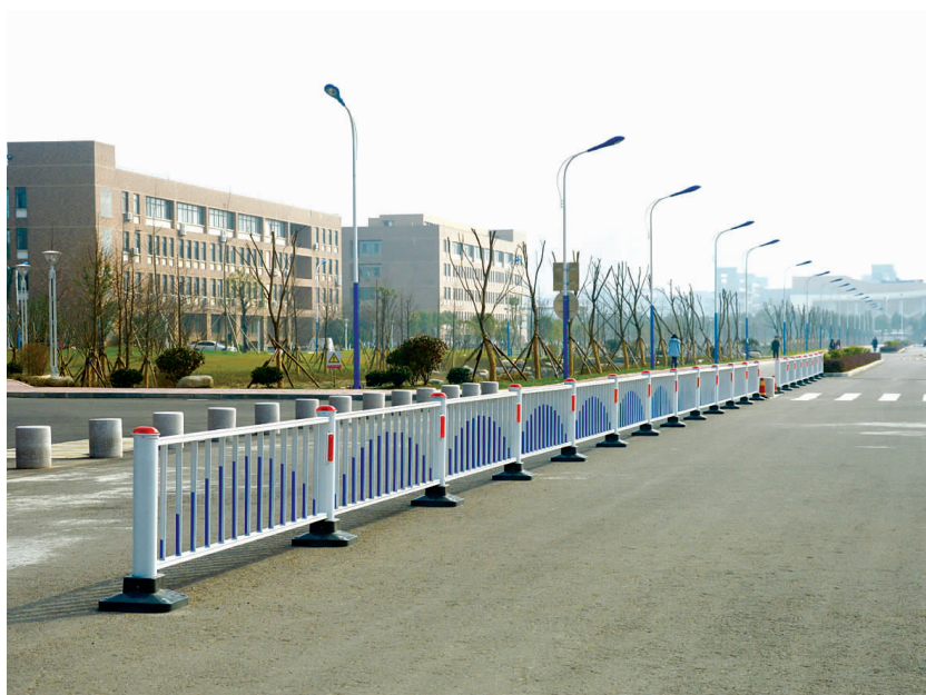
为打造新学期的安全校园，椒江校区于寒假期间完成建立护栏、施划道路交通标线等安全建设。图为图书馆南侧马路上建立护栏、施划人行横道线。
